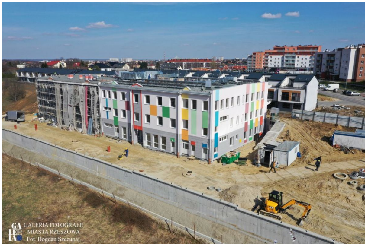
Żłobek i przedszkole przy ul. Iwonickiej, fot. B.Szczupaj, Galeria Fotografii Miasta Rzeszowa
